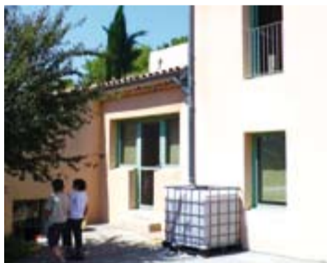
La cuve de récupération des eaux de pluie installée dans la cour permet d'arroser le potager de l'école réalisé par les enfants.
