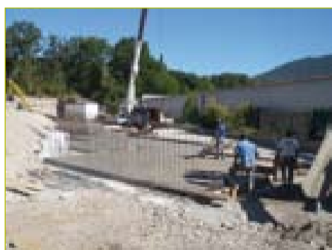
6 Le coulage des dalles
