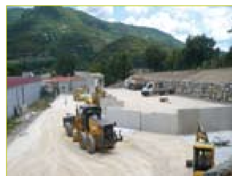
7 La préparation de la voirie et le passage des réseaux
