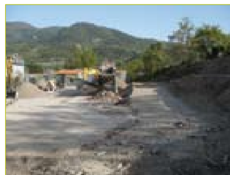
3 Le terrassement du terrain et la récupération des métaux
