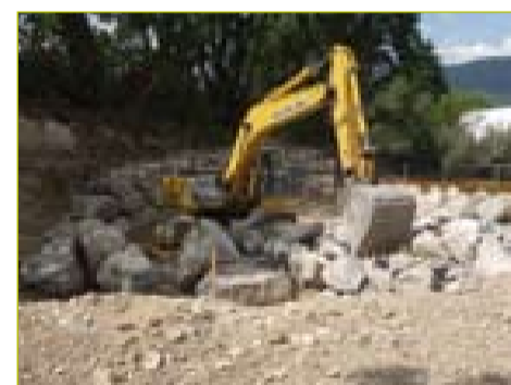
4 La préparation des niveaux (bas et haut ainsi que l'enrochement)
