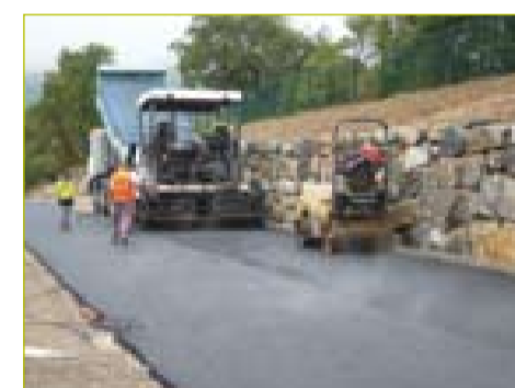
8 La création de la sous couche des enrobés
