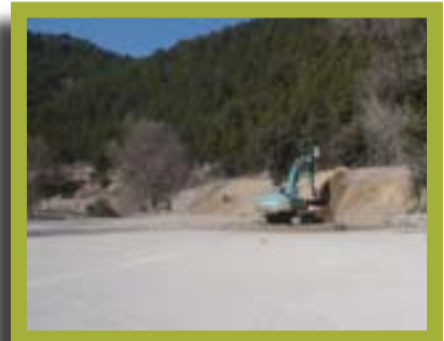
Premiers travaux de terrassement
