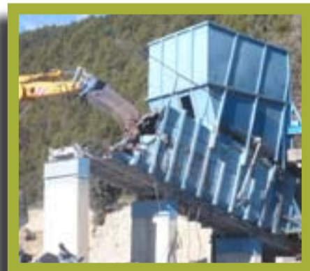
Démantèlement de l'ancien quai de transfert des ordures ménagères
