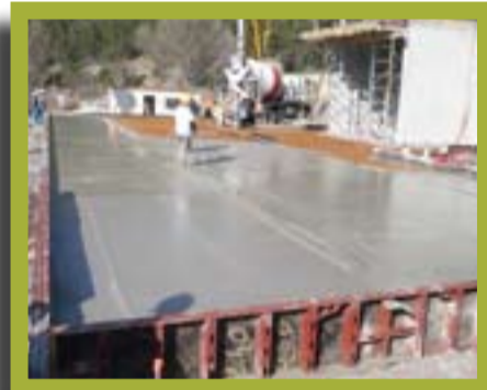
Réalisation de la structure béton
